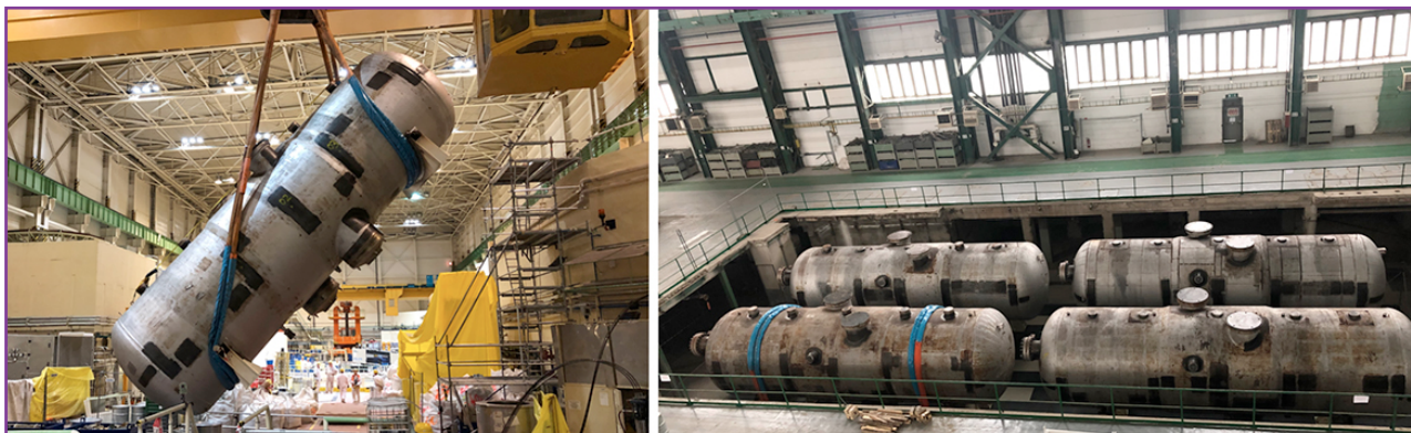
Figura 4. Extracción y transporte de generadores de vapor horizontales. Acopio final previo a la fragmentación.
