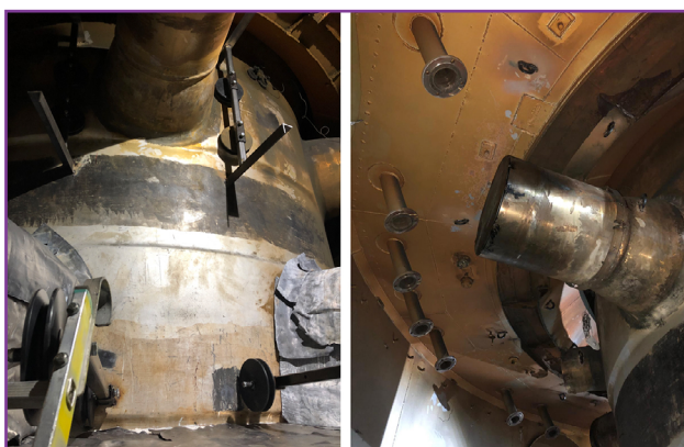
Figura 5. Desconexión de la vasija del reactor.
