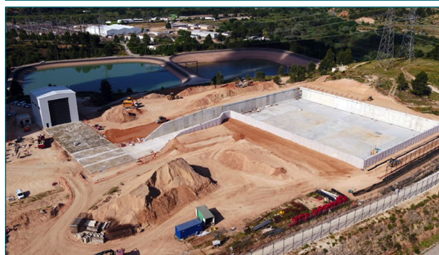
Estado actual de las obras del ATI.
