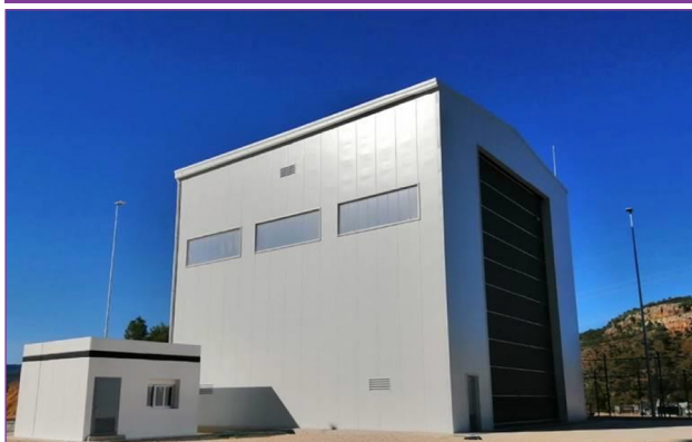
Figura 4. Vista edificios auxiliares.
