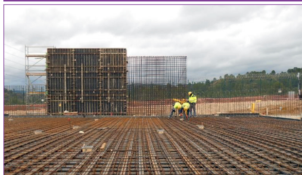
Figura 6. Fotografía disposición armado losas.
