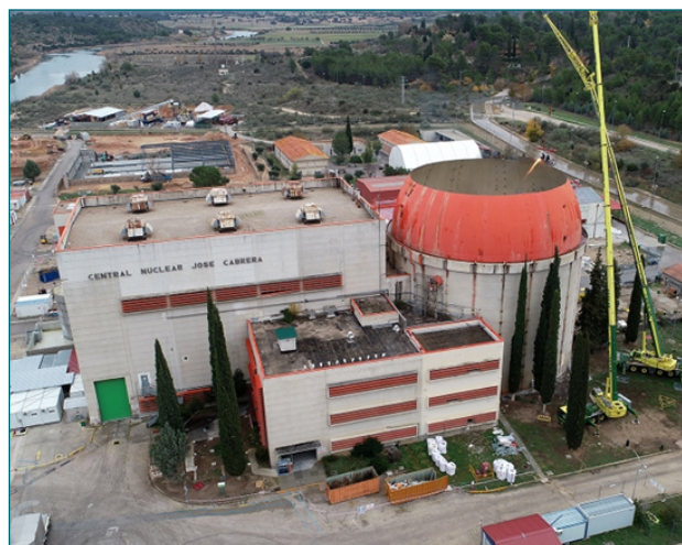
Ilustración 3. Desmantelamiento cubierta edificio contención C.N. José Cabrera.
