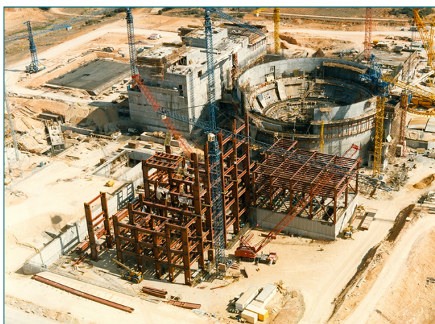
Ilustración 2. Construcción de la C.N. de Trillo. Evidencia del salto tecnológico y en seguridad.
