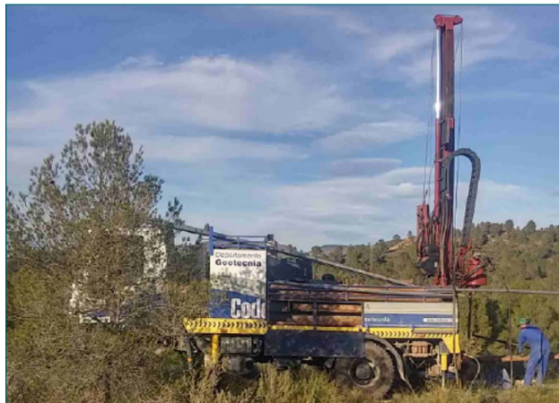
Figura 2. Sondeos geotécnicos en campo.
