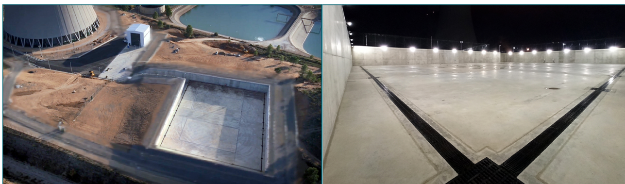
Figuras 29 y 30. Estado final de la instalación construida
