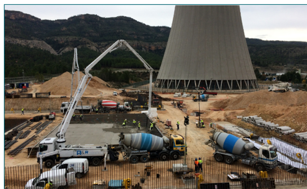
Figura 21. Hormigonado losa Sur.
