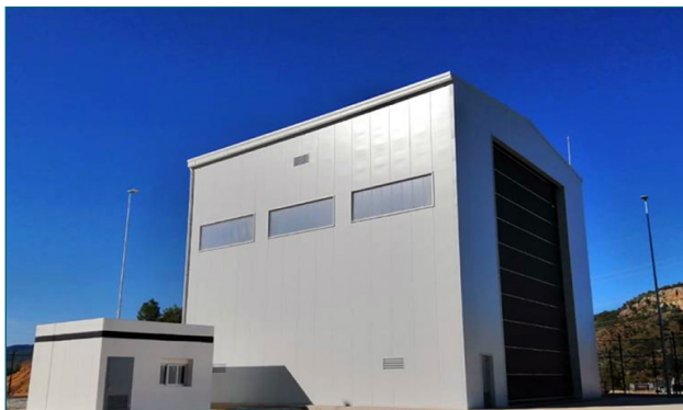
Figura 13. Vista edificios auxiliares.
