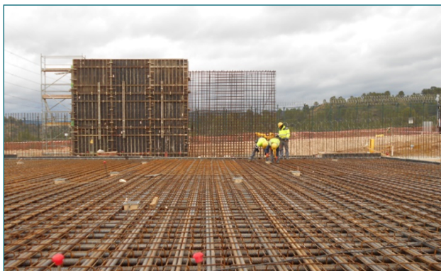
Figura 15. Fotografía disposición armado losas.
