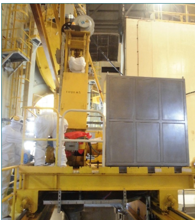
Figura 9. Trabajos de renovación de la manipuladora de contención.
