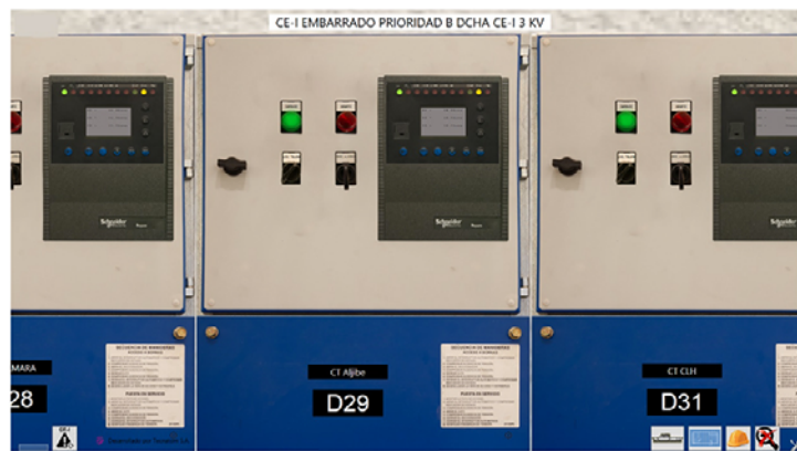
Figura 5. Nivel 2. Detalle de cabinas.
