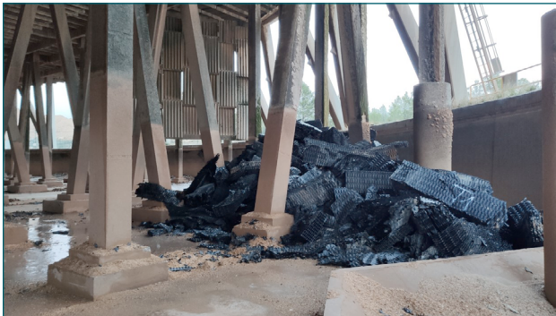
Figura 10. Retirada de los paquetes de relleno.
