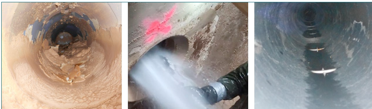
Figura 7. Estado inicial de tuberías, proceso de limpieza y estado final.
