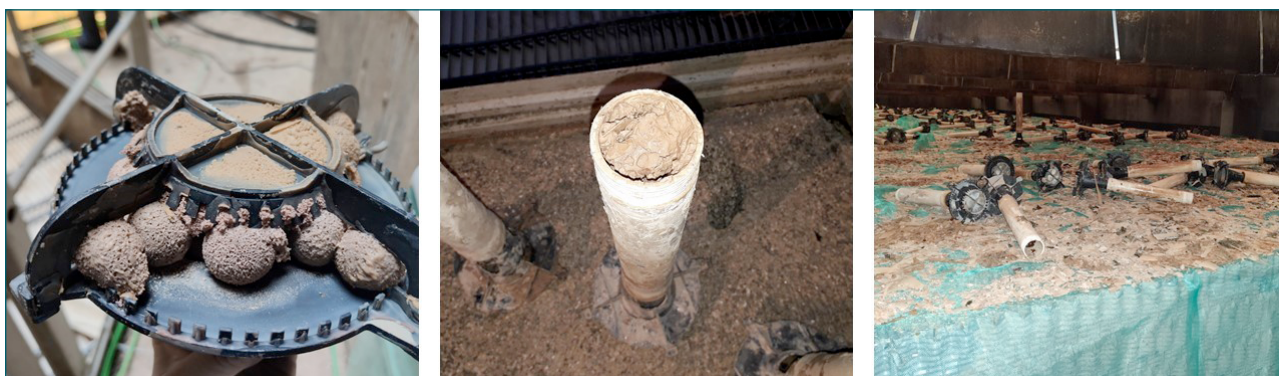
Figura 6. Estado previo de dispersores.
