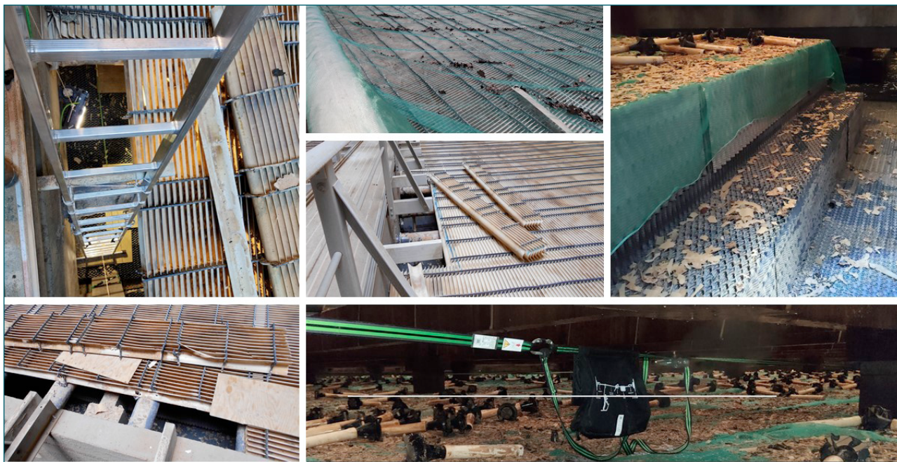
Figuras 5. Distintas imágenes de la implantación interior.
