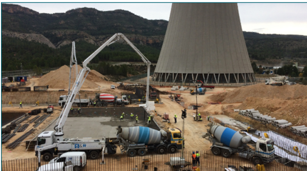
Imagen 3. Hormigonado losa Sur.
