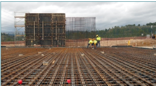
Imagen 4. Armado de las losas.
