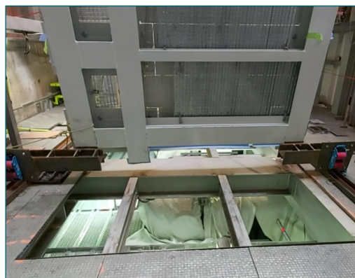
Imagen 22. Maniobra de introducción de nueva bancada.
