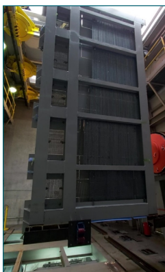
Imagen 21. Maniobra de introducción de nueva bancada.
