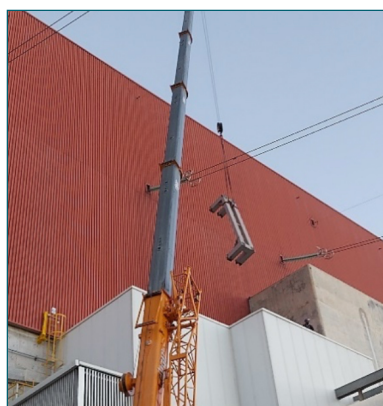
Imagen 15. Retirada de la bancada de un polo.
