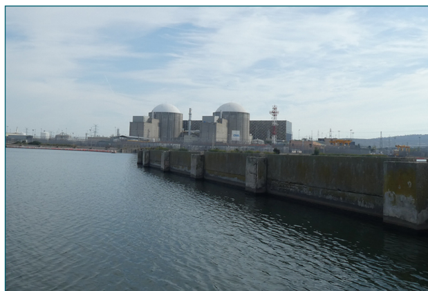
Inspección de estructuras acuáticas.
