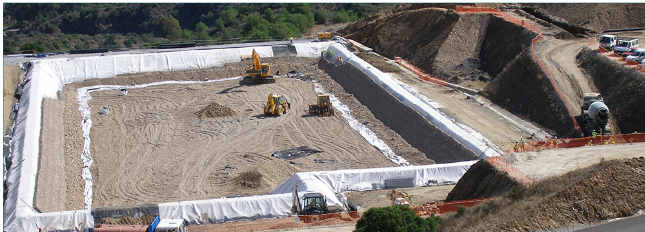
Foto 1. Proceso de construcción (en 2007) en la instalación de Enresa en El Cabril dedicado al depósito de las detecciones del Protocolo y asimilables. Fuente: propia.
