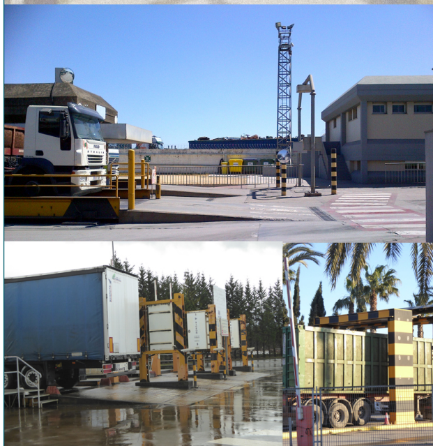
Foto 2. Esquema de procedimiento en caso de alarma en Pórticos de Vigilancia. Elaboración propia UNESID/FER a partir de información trabajo del PCVRMM. Fotografías de diferentes modelos de pórticos de vigilancia radiológica. Fuente propia.
