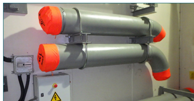
Figura 6. Preparación de trabajos realizada en 2021 para la nueva conexión entre el sistema de agua de servicios esenciales y el sistema de extracción de calor residual.
