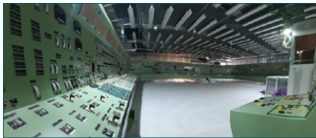
Foto 5. Instalación de los paneles en bancadas.
