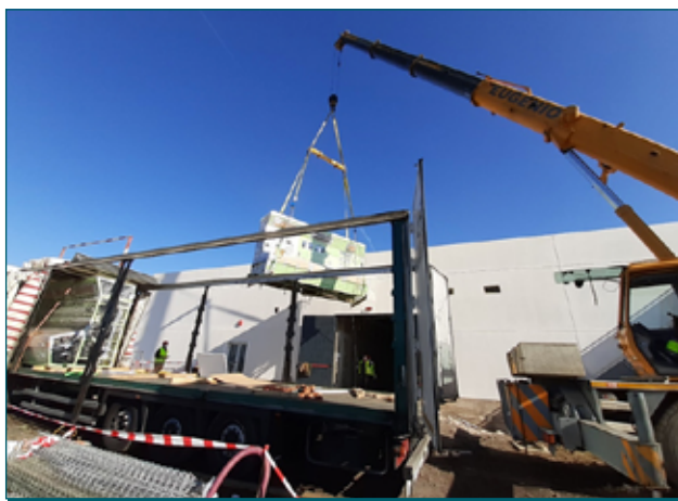
Foto 4. Introducción de los paneles en el nuevo edificio.
