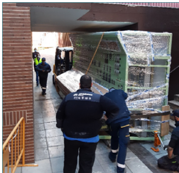
Foto 3. Extracción de las consolas.
