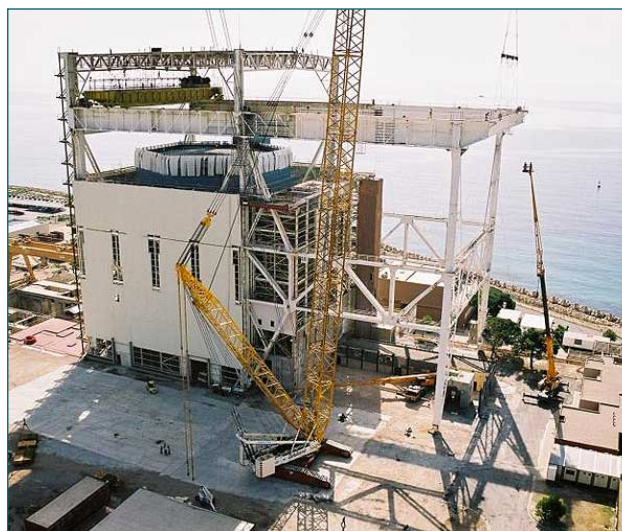
Desmontaje de la nave del Reactor de C. N. Vandellós 1
