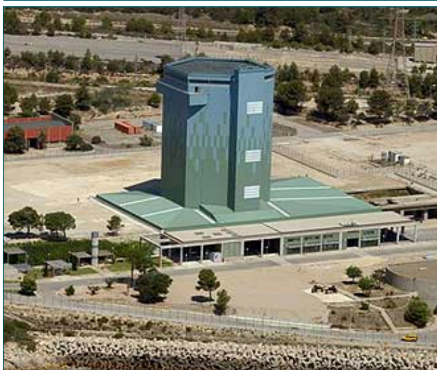
El actual edificio del reactor de C. N. Vandellós 1.
