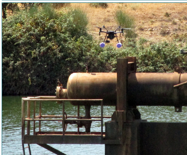
Figura 9. RPAS posicionado para inspección visual de final de línea.
