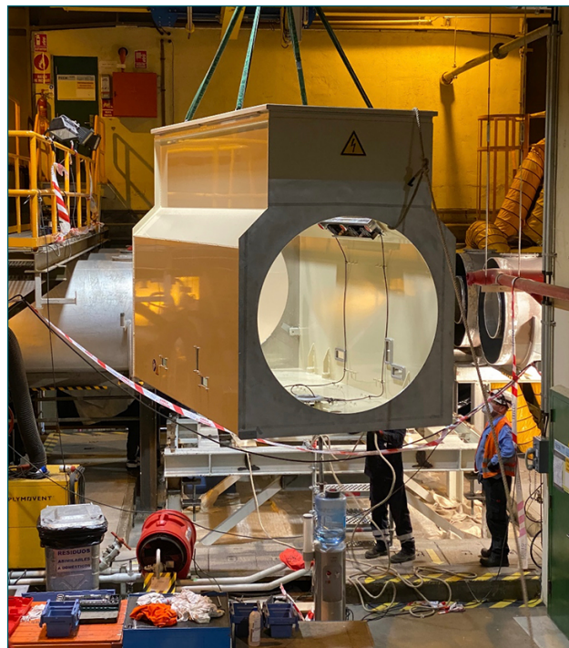
Imagen 20. Proceso de montaje del interruptor. Traslado de la carcasa de uno de los polos del nuevo interruptor a través del recinto.
