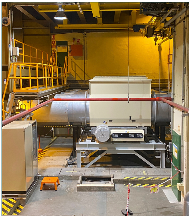
Imagen 22. Nuevo interruptor de generación ya montado en C.N. Trillo.
