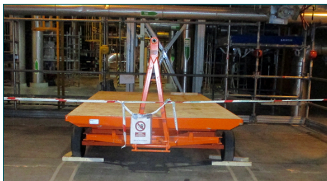
Imagen 13. Trolley para desplazamiento de los equipos por cota +0.000.
