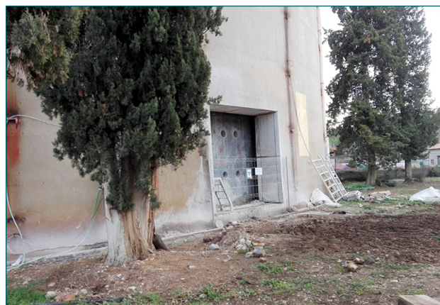
Nueva puerta de acceso a la contención construida durante el desmantelamiento. Fuente: CSN
