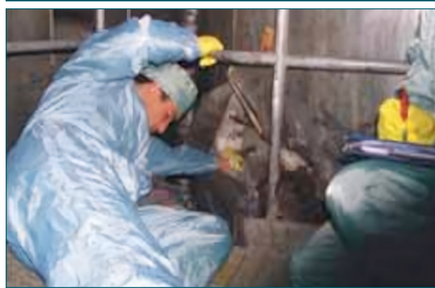
Caracterización del generador de vapor en zonas poco accesibles. Fuente: Enresa
