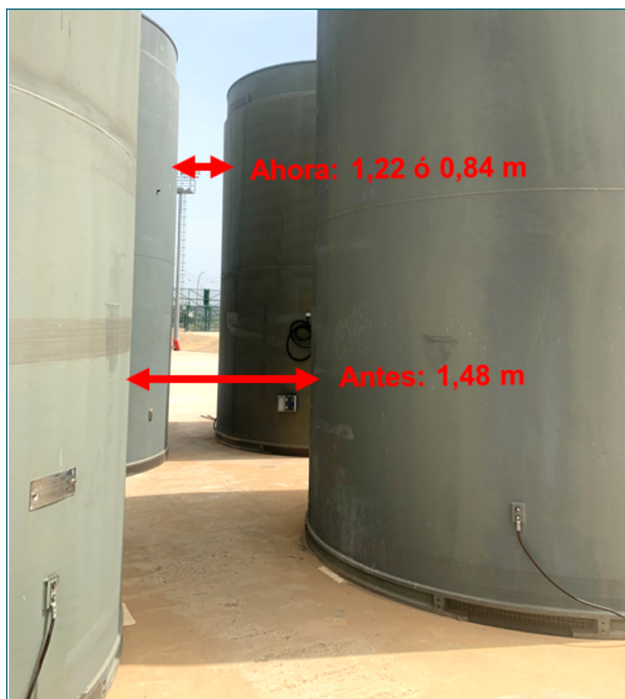
Figura 2. Configuración del ATI de C. N. Ascó (inicial – tras densificación).
