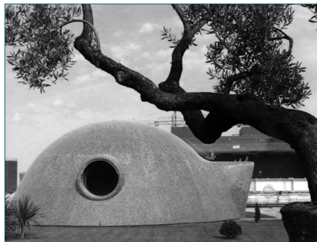
Figura 4. Pabellón telefónico (1972). Cortesía del Archivo Municipal de Vandellòs i l'Hospitalet de l'Infant.
