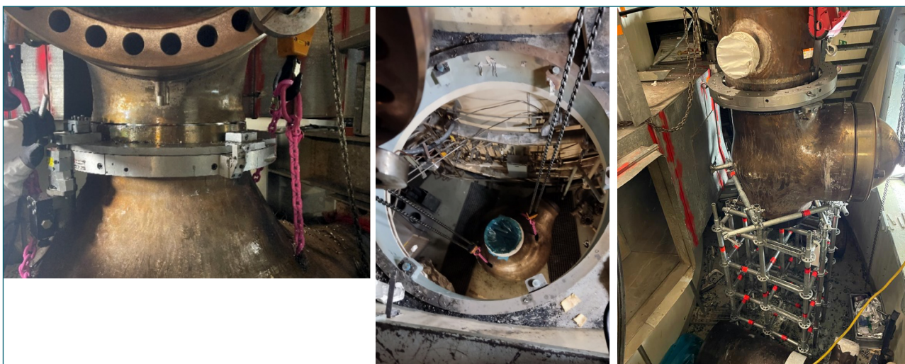
Figura 11. Instalación máquina de corte (a la izquierda), izado carcasa con cadenas y puente grúa (al centro), instalación máquina de corte y estructura en andamio para retirada de válvula del sistema 313 (a la derecha).
