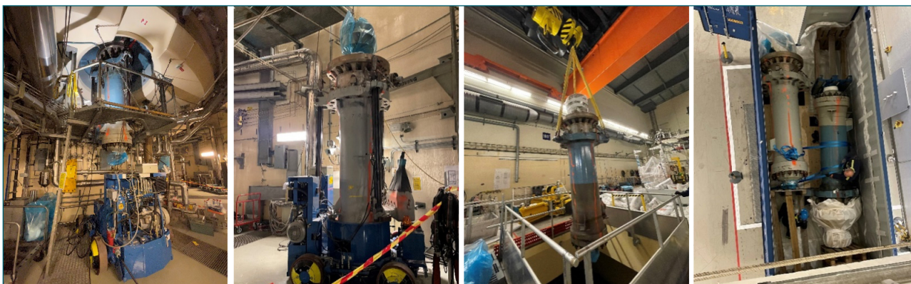
Figura 10. Enganche sistema hidráulico de bajada motor (foto de la izquierda), traslado por medio de carro, izado con puente grúa y acondicionamiento en contenedor ISO 20'.
