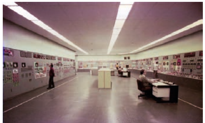
Primeros años de funcionamiento de la central
