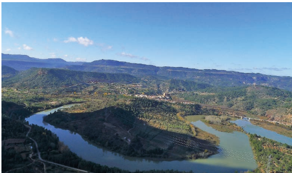
Protección radiológica de los vecinos del entorno y del medioambiente.
