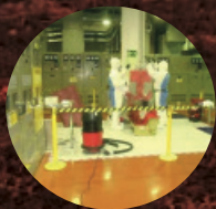
Desmontaje de Interruptores de 6,3kV con protocolo de retirada de fibrocemento
