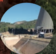
Limpieza de pilares en las torres de circulación
