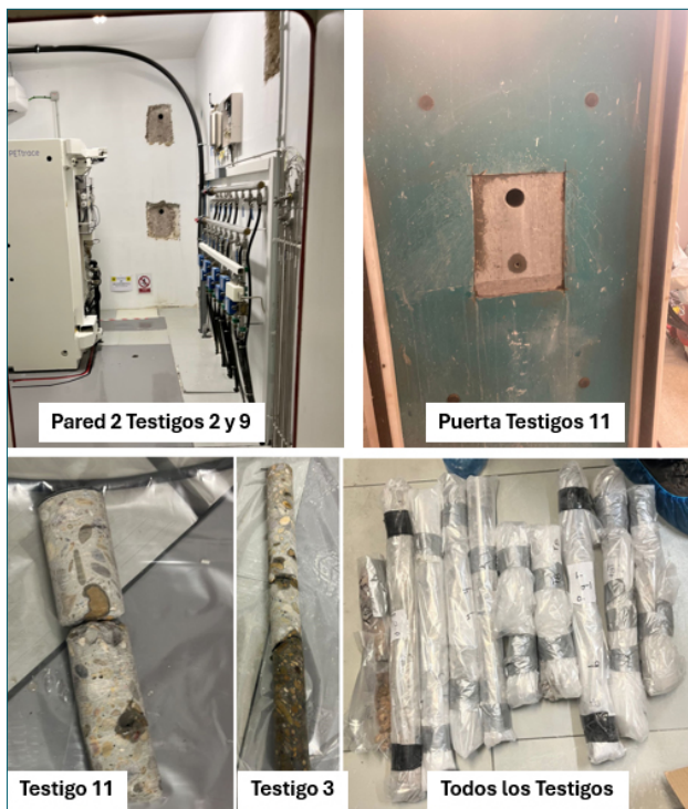
Figura 7. Testigos de hormigón extraídos en la puerta, suelo y paredes del búnker.
