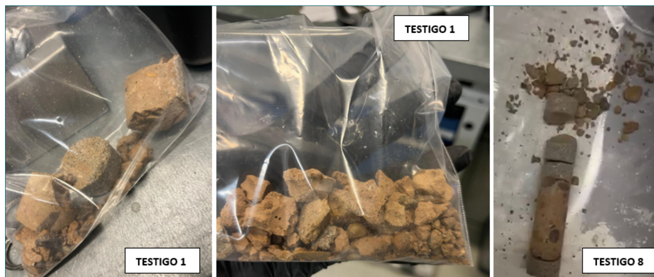
Figura 6. Testigos 1 y 8 extraídos en el muro construido con bloques de hormigón prefabricados.
