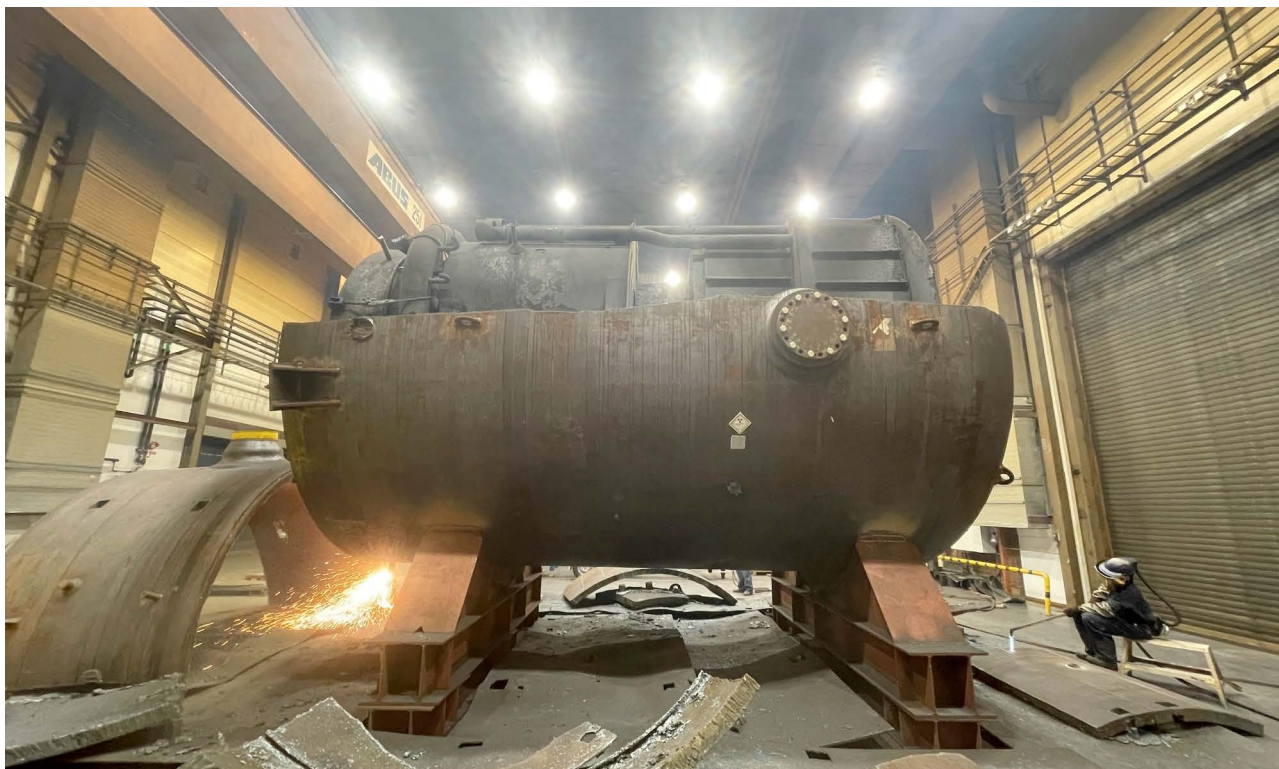
Figura 1. Operación de corte de la parte superior de un generador de vapor, dentro del taller de gestión de grandes componentes en Cyclife en Suecia. (Fotografía cortesía de Cyclife)
