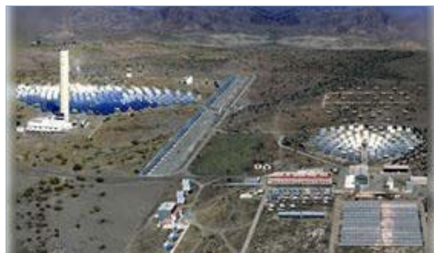
Plataforma solar de Almería.
