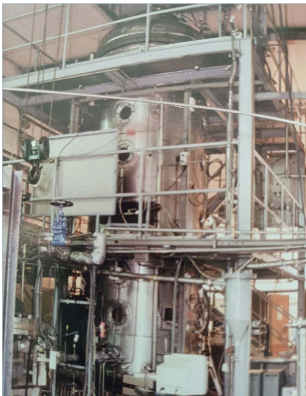
Instalación PECA para el estudio de aerosoles en accidentes severos.
