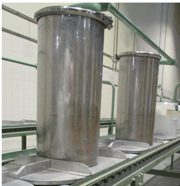
Figura 3. Bidones de \text{UO}_2 en el Almacén de Cuarentena, manteniendo una configuración geométrica segura gracias al diseño del almacén.
