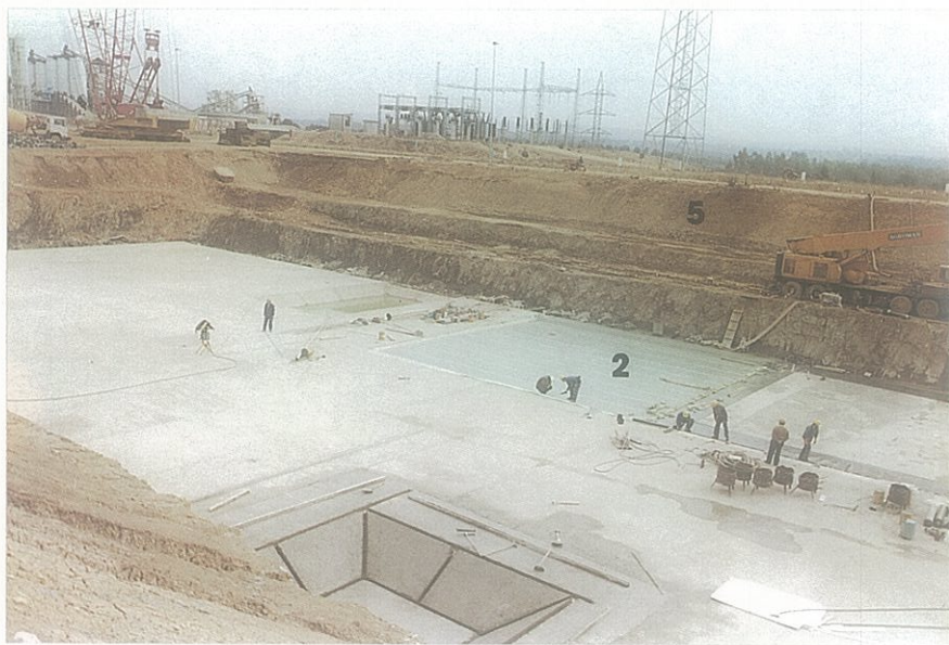
Impermeabilización horizontal de la losa de cimentación del edificio de residuos radiactivos.
