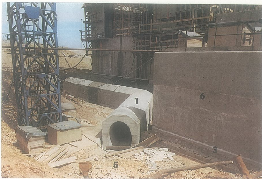
Sección transversal de la galería perimetral de drenaje en el edificio de turbinas.
