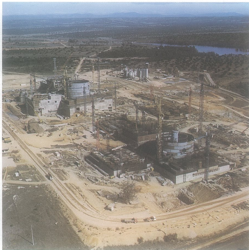
Vista general del emplazamiento.
