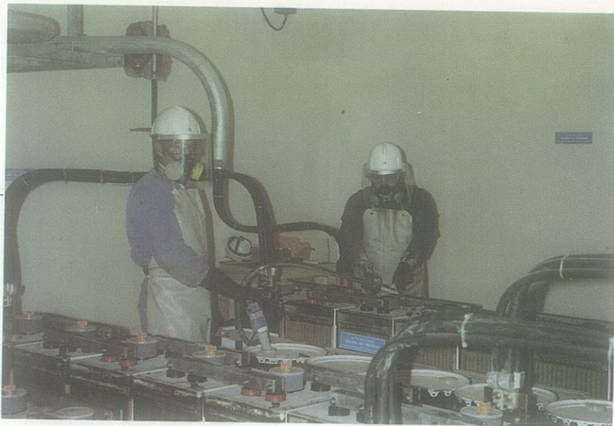
C. N. Cofrentes. Montaje de batería de 2.000 A/h.
