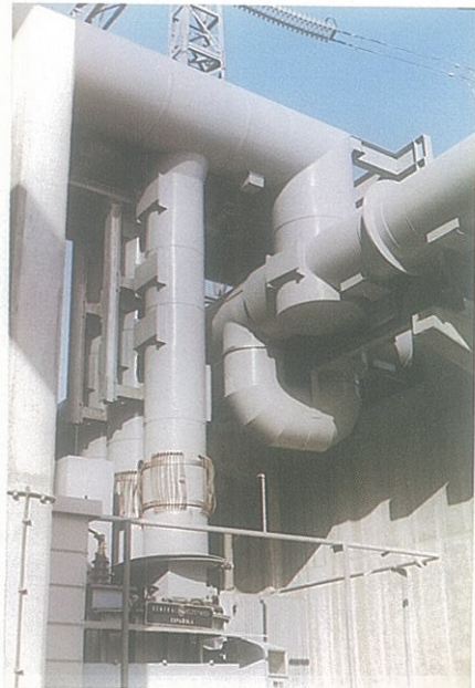
C. N. Ascó. Montaje de barras de fases aisladas.
