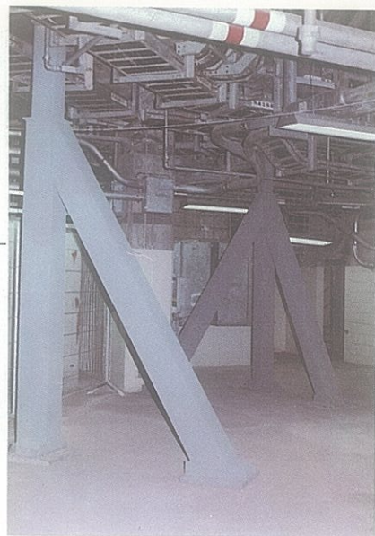
C. N. Ascó. Soportes y riostras de bandejas.
