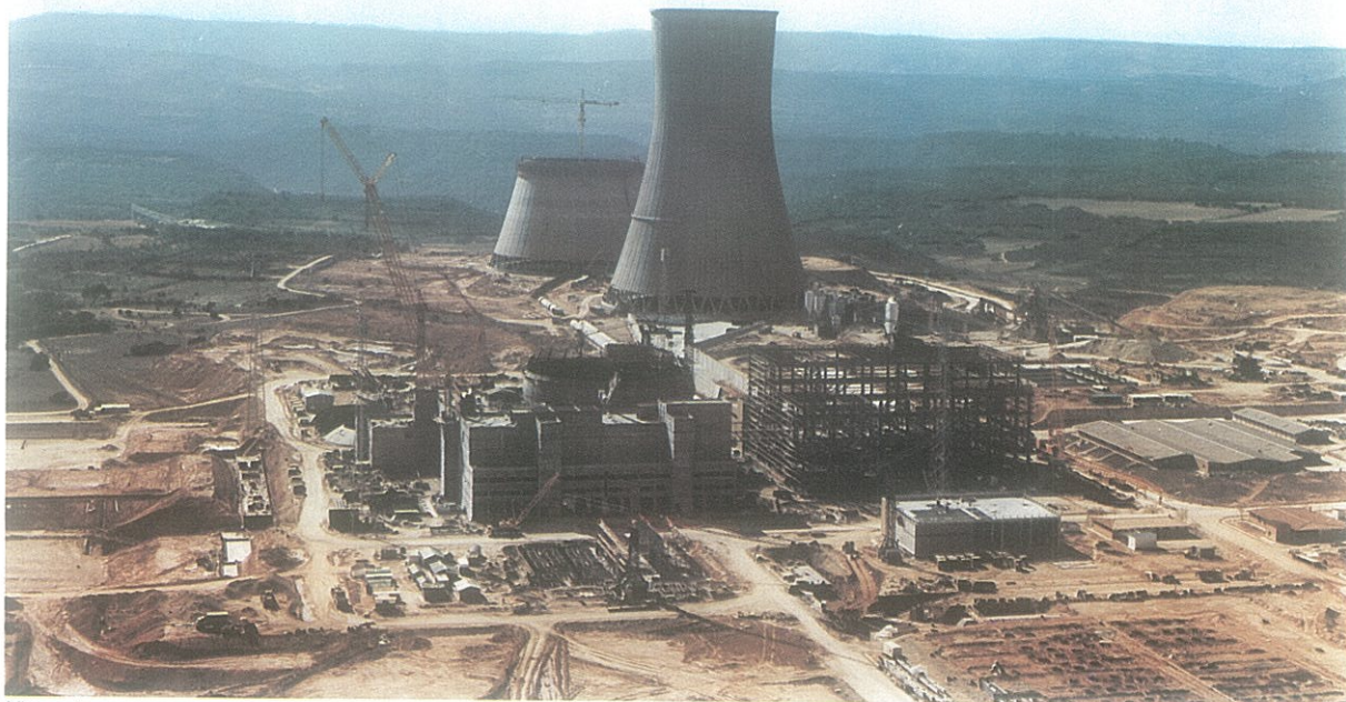
Vista aérea de la C.N. Trillo, en construcción.
