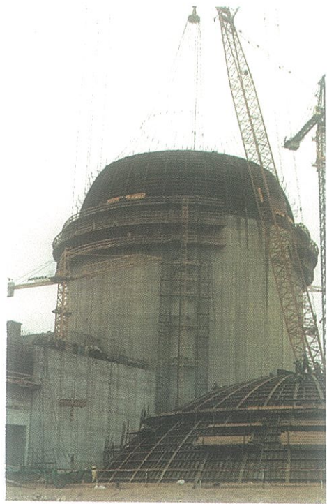
F VI Edificio de contención después de montarse la primera sección de la cúpula (15-3-84).
