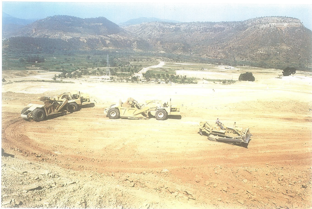
Explanación de los terrenos de la Central (17-5-74)
