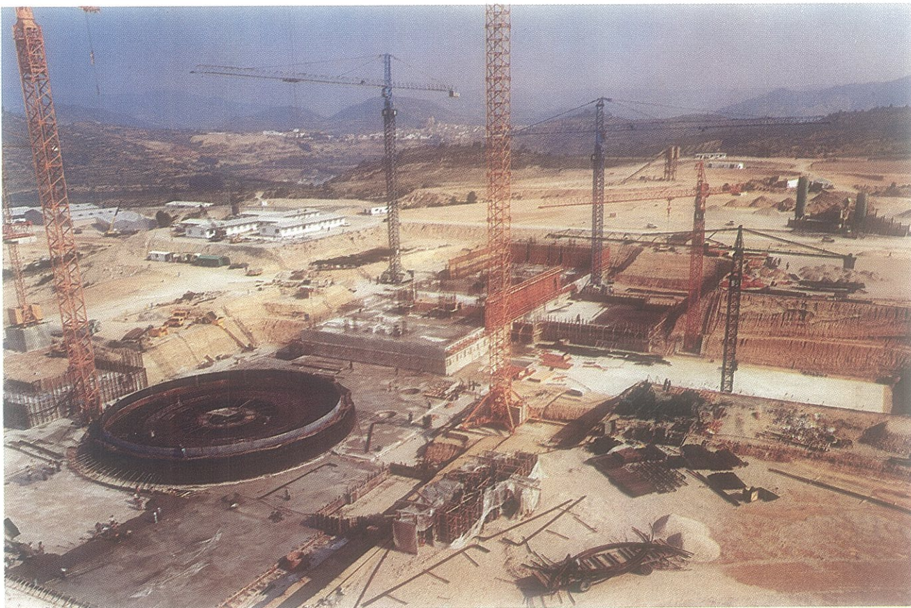
Vista general de las obras. En primer término, montaje de la ferralla del edificio del reactor
