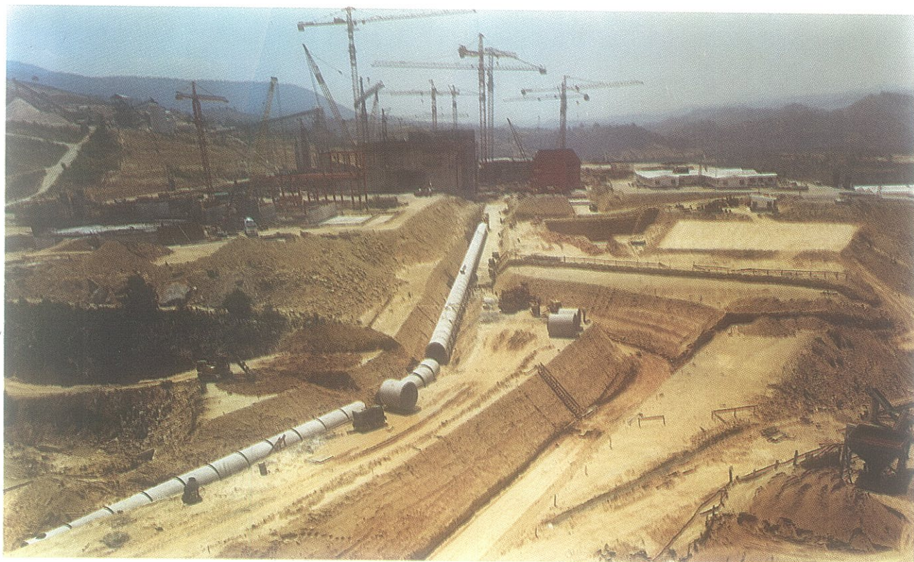
Canal de impulsión. Montaje de la tubería forzada
