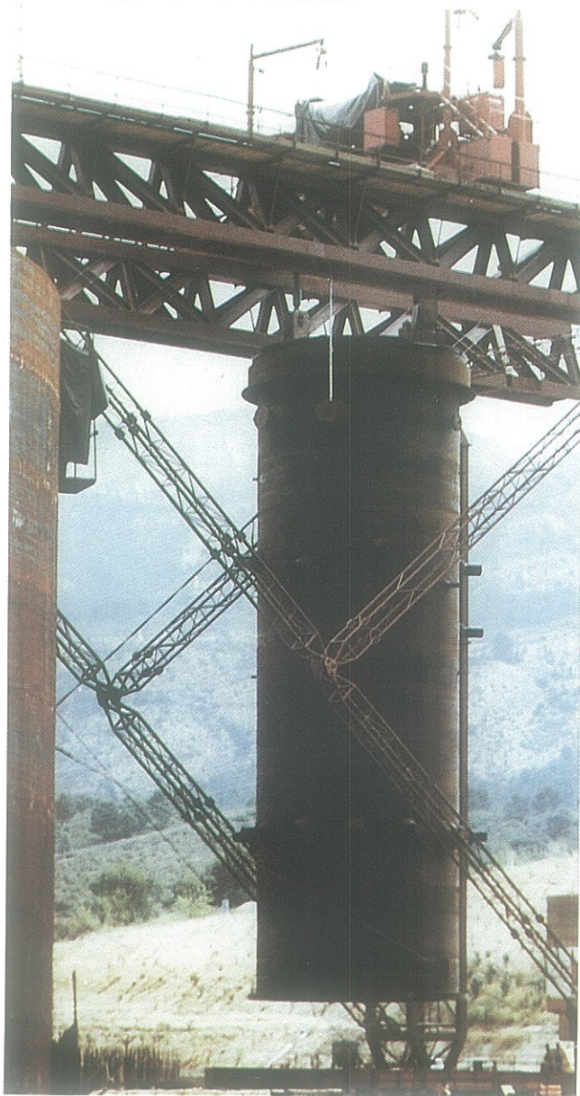
F VI Liberada de su bastidor de transporte, la vasija del Reactor se desplaza a su alojamiento definitivo.
