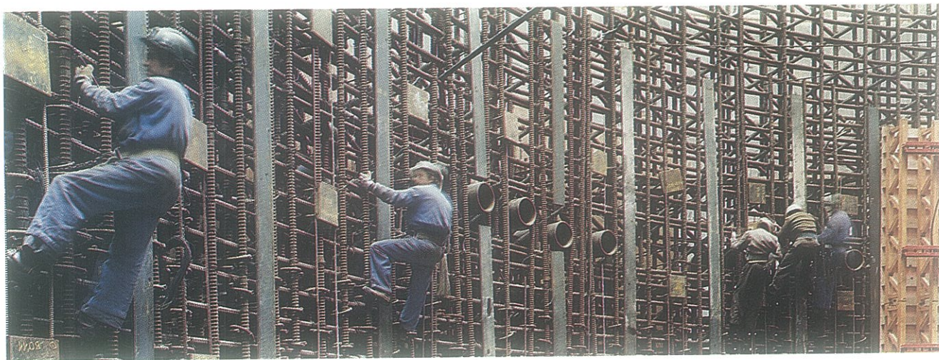
Armadura del edificio del reactor
