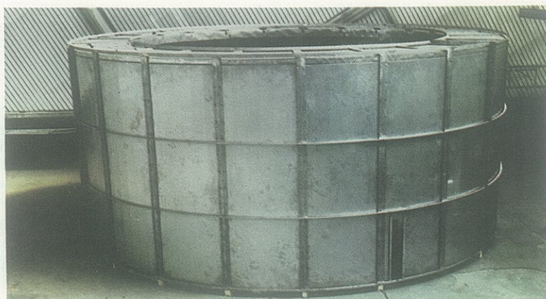
Aislamiento reflexivo del cuerpo de la parte superior del reactor
