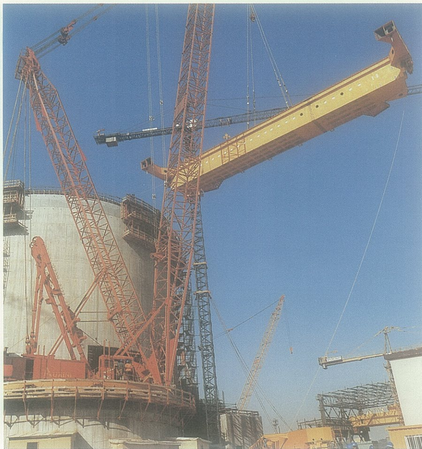
Montaje primer tramo largo vigas grúa polar (marzo 1984).
