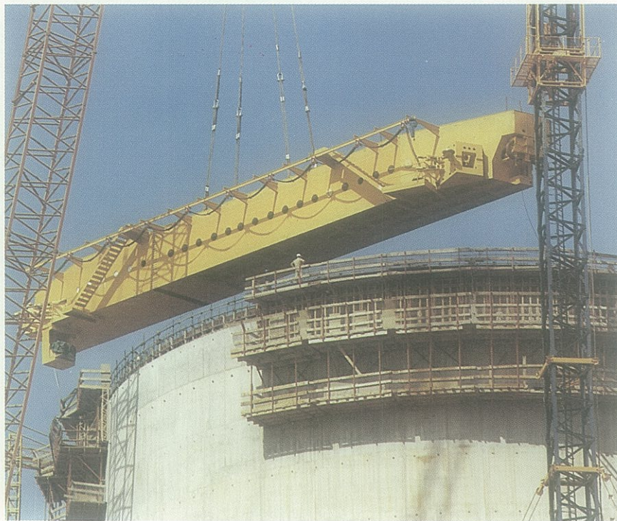
Montaje primer tramo largo vigas grúa polar (marzo 1984).
