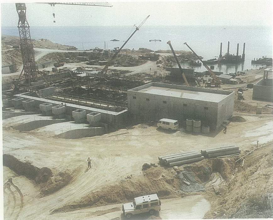
Casa de Bombas (agosto 1984).
