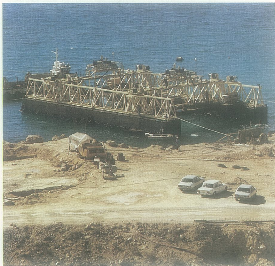
Catamarán para el traslado y fondeo de los cajones de toma de agua.
