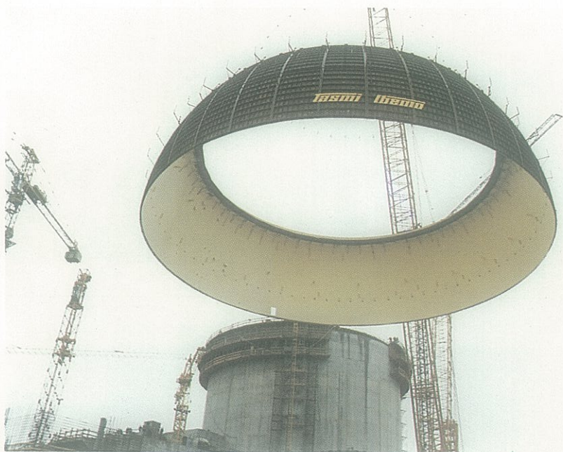
Colocación de la primera pieza de la Cúpula (marzo 1984).
