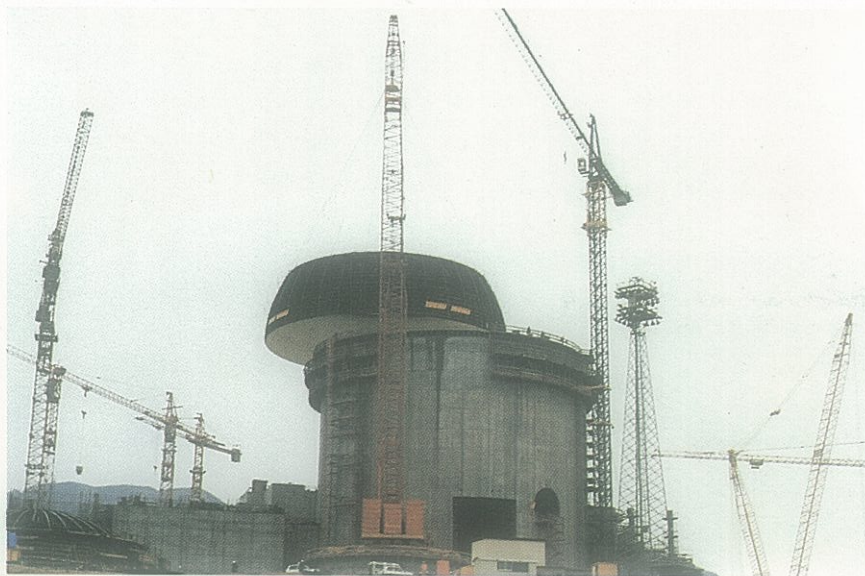
Colocación de la primera pieza de la Cúpula (marzo 1984).
