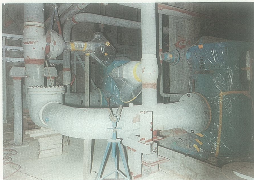
Edificio de Turbinas: detalle del Mantenimiento de Equipos durante las obras.
