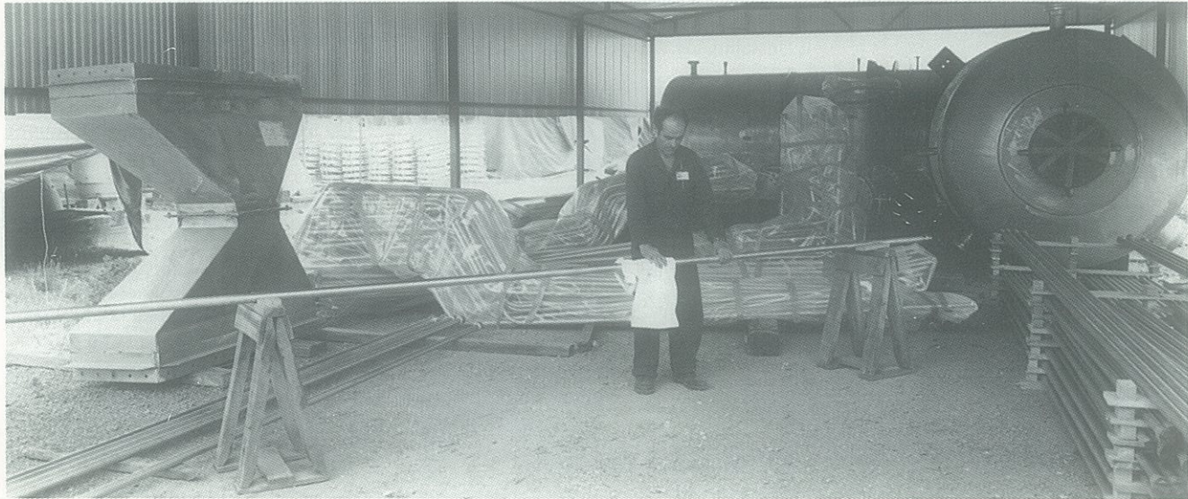
Trabajos de limpieza y precintado de tuberías de accionamiento de las barras de control.
