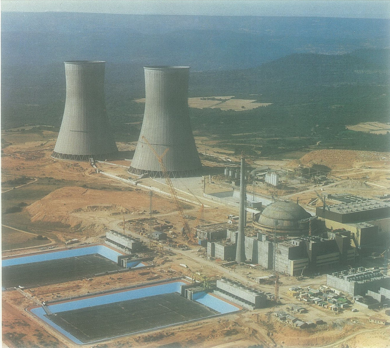
Obra de la central nuclear Trillo I.
