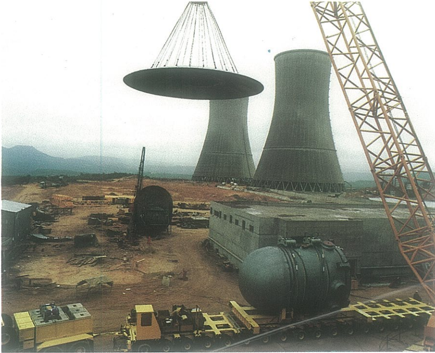
izado del último sector de la esfera de contención.
