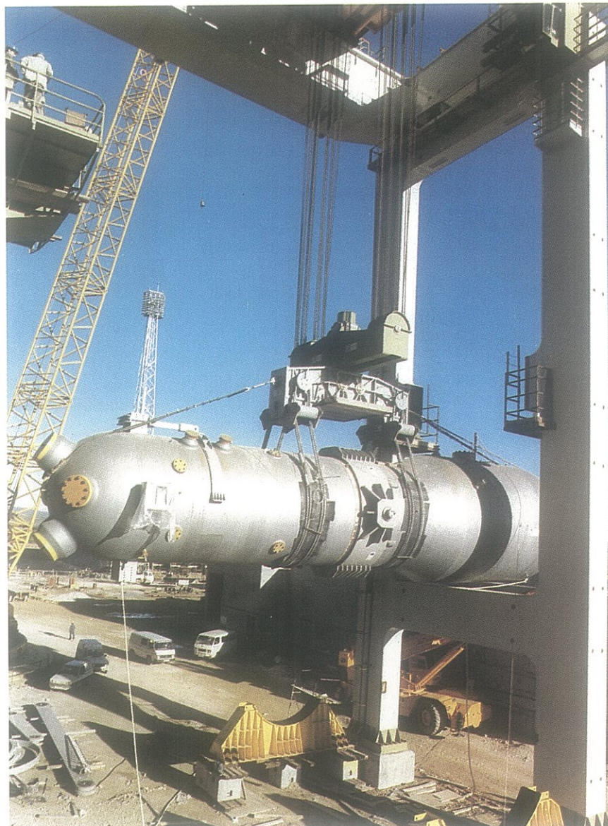
Comienzo izado generador vapor.
