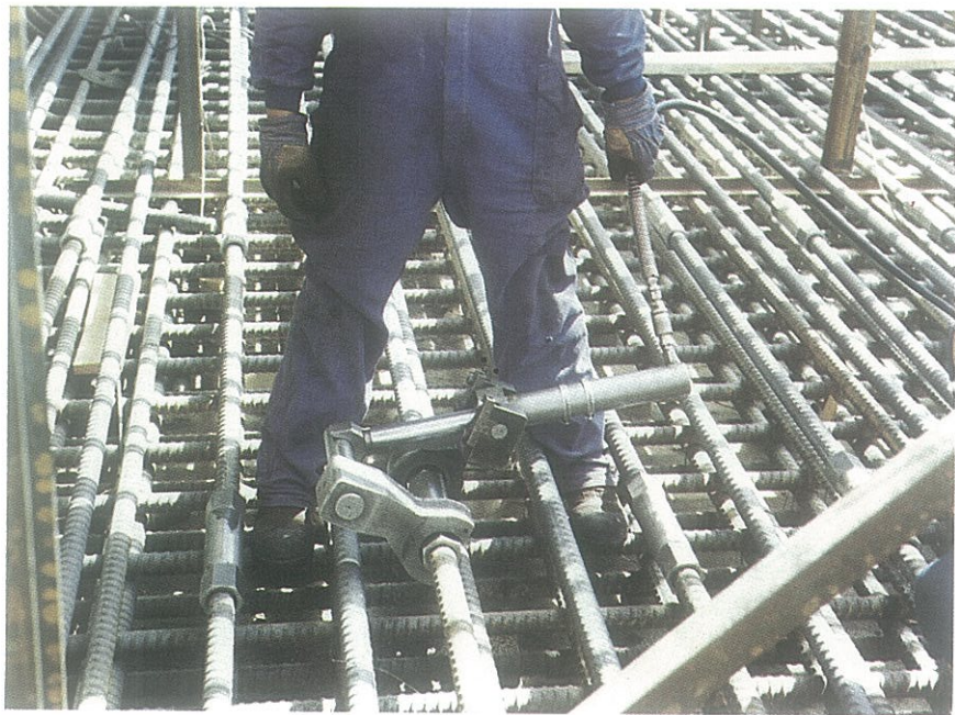
Instalación de uniones Gewi, 29-7-81.
