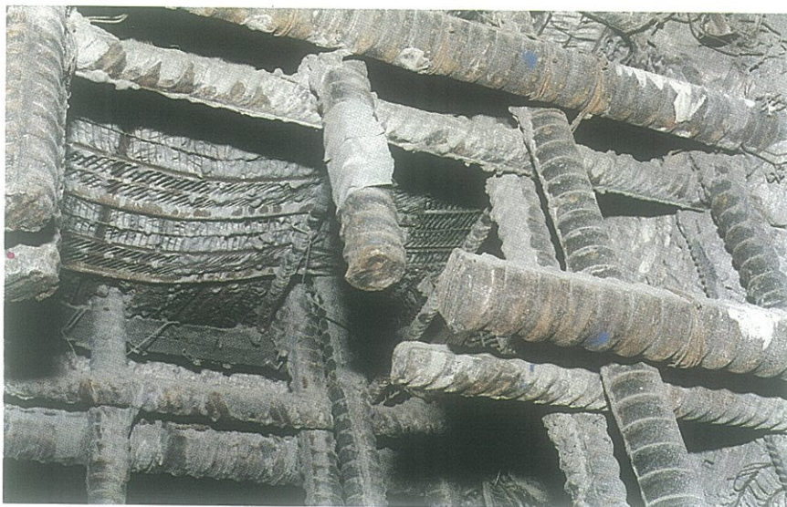
Reforzamiento de armadura a huecos.
