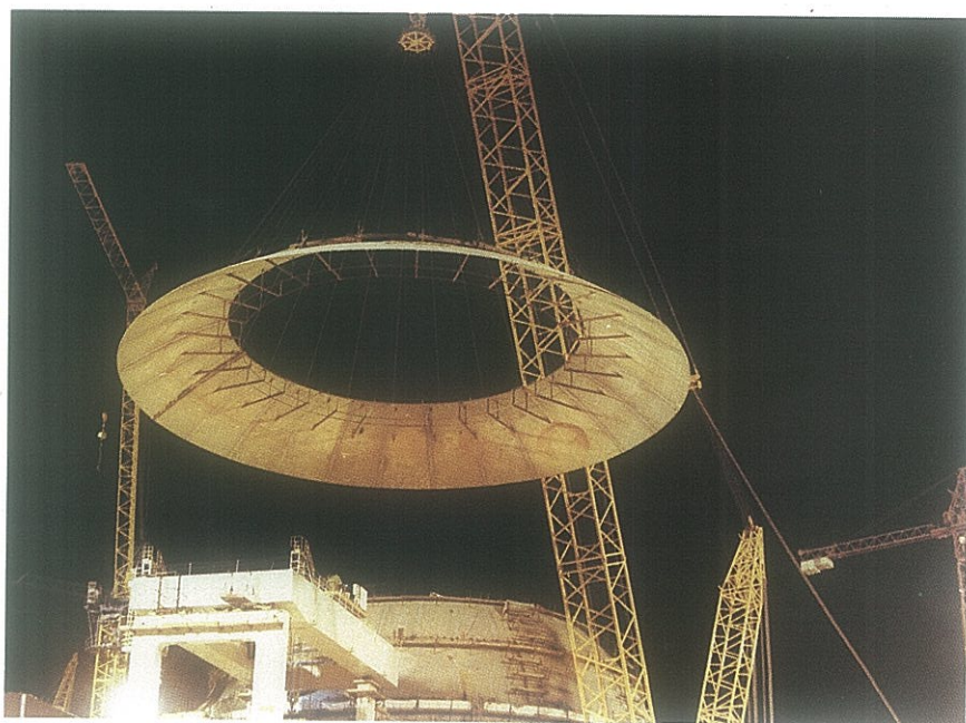
Finalizado de la penúltima zona de la esfera de contención.
