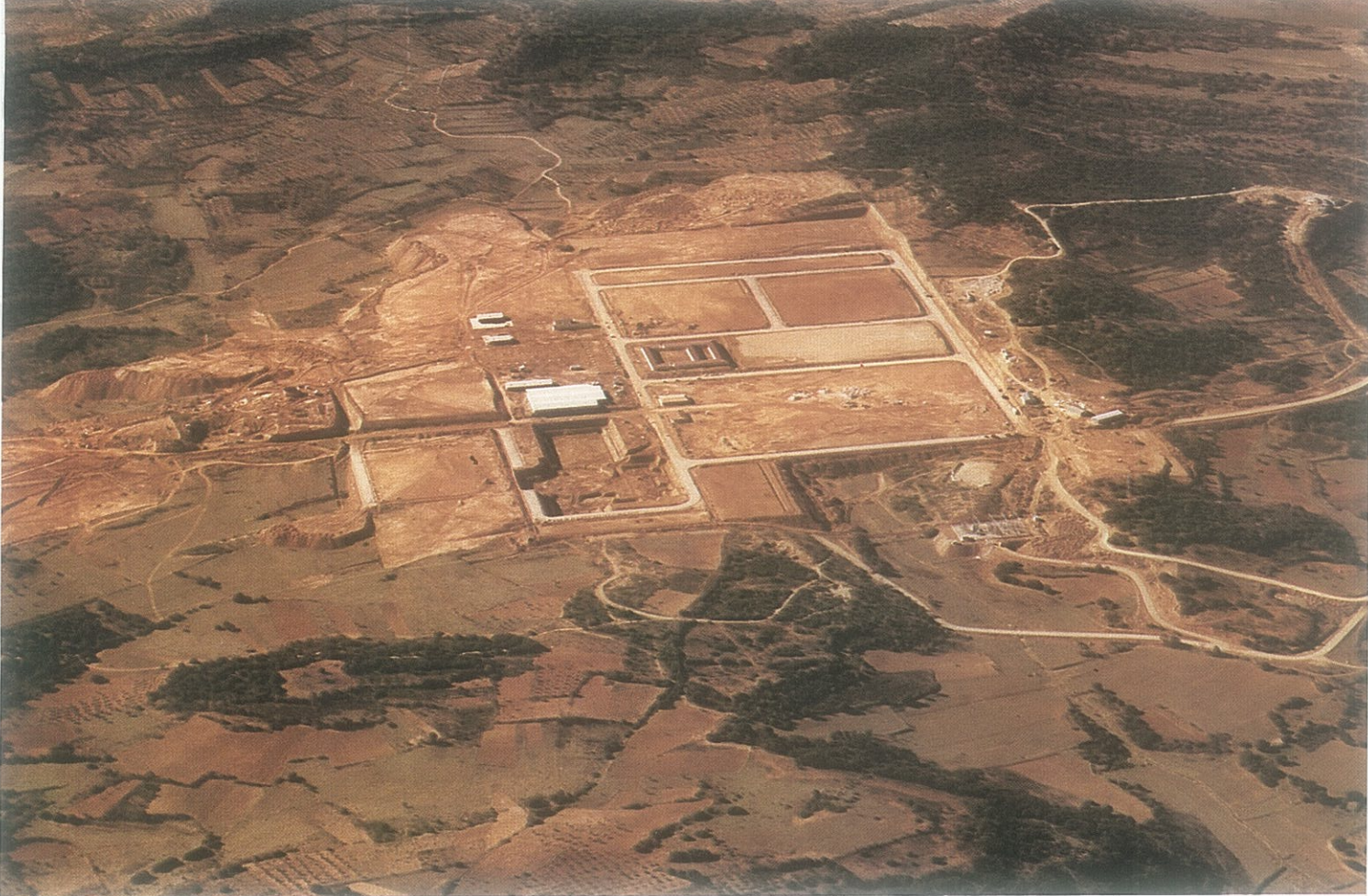
▲ Enero-1978. Vista aérea de accesos; almacén (parte derecha) e infraestructura del emplazamiento (centro). También se aprecia el vaciado para los edificios de la central.
