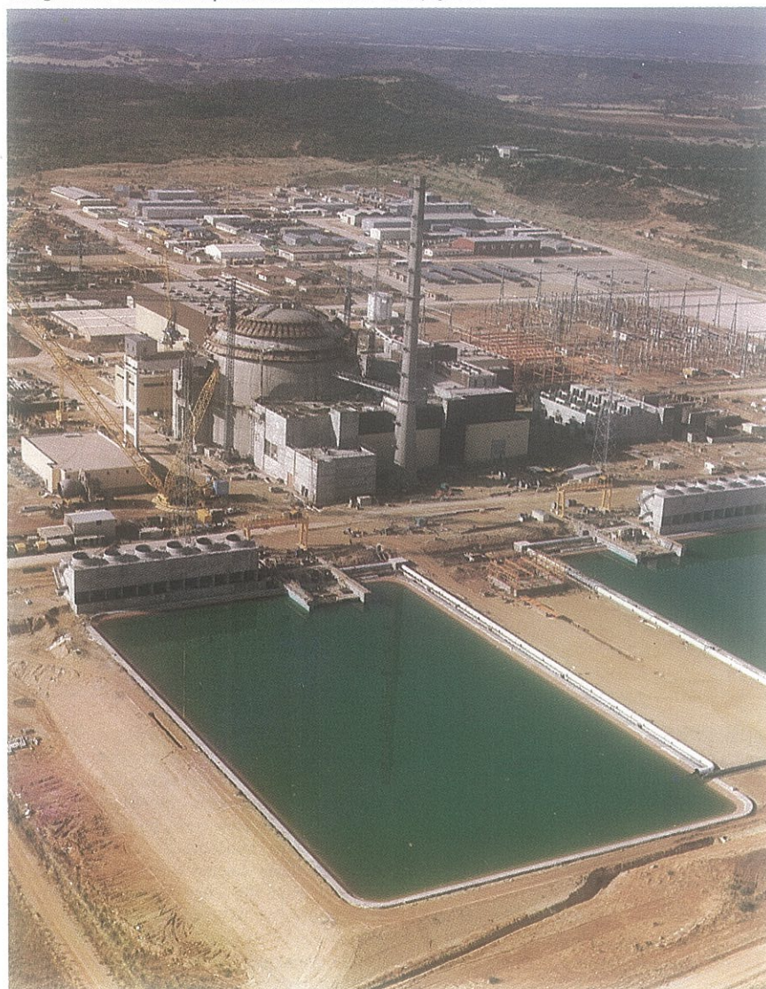
Vista general al 30-11-85. En primer término. Piscina de Refrigeración de Servicios esenciales.
