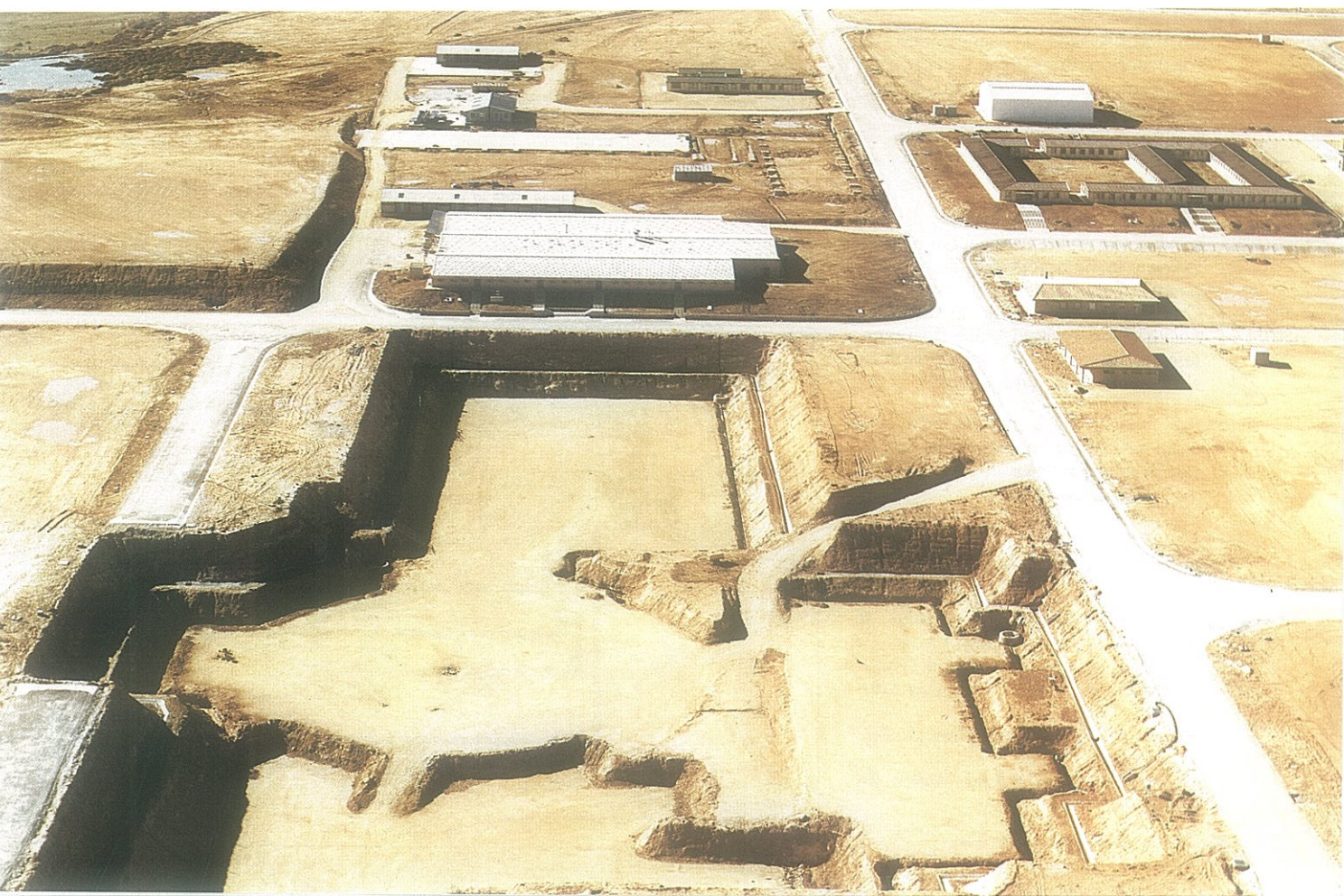
Vista general. Situación en enero-1979. En primer plano, excavación para los edificios de la central. ▼
