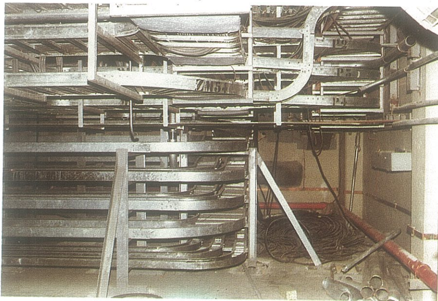
Nuevo tendido de bandejas.
