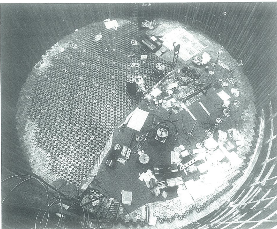
FX Montaje del primer lecho de grafito en el apilamiento del núcleo (foto Jacques).
