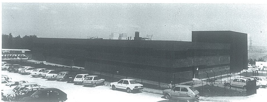
F IV Vista de la sede de TECNATOM, S. A. con la nave que alberga la Instalación Radiactiva.
