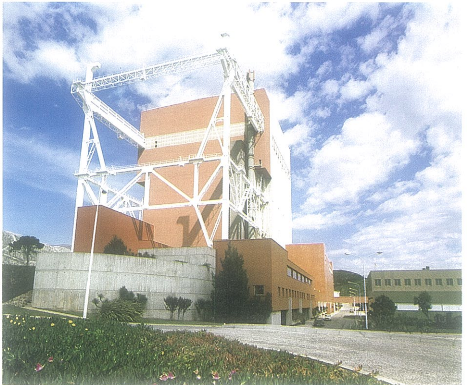
Vista general de la Central
