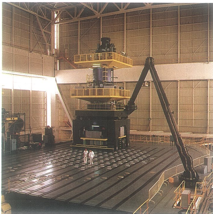
Dispositivo principal de manutención del combustible. La renovación del combustible nuclear se efectúa mediante el acoplamiento de la máquina de carga al recinto de presión, estando el reactor habitualmente en potencia durante esta operación.
