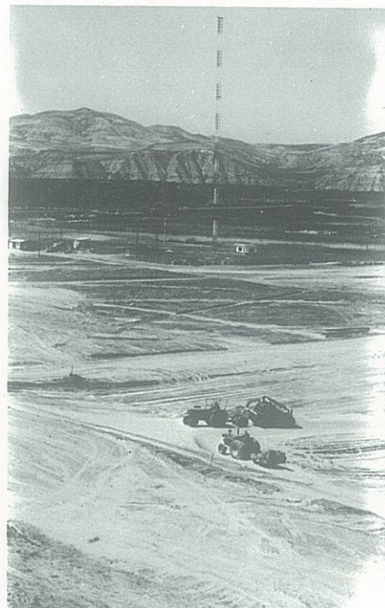
Instalación meteorológica e iniciación de los trabajos de explanación. Junio 1965
